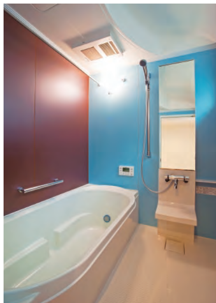
▲ドライルームを兼ねた洗面と「R+house」(アール・プラス・ハウス)オリジナルUB。色や形のバリエーションも豊富です
